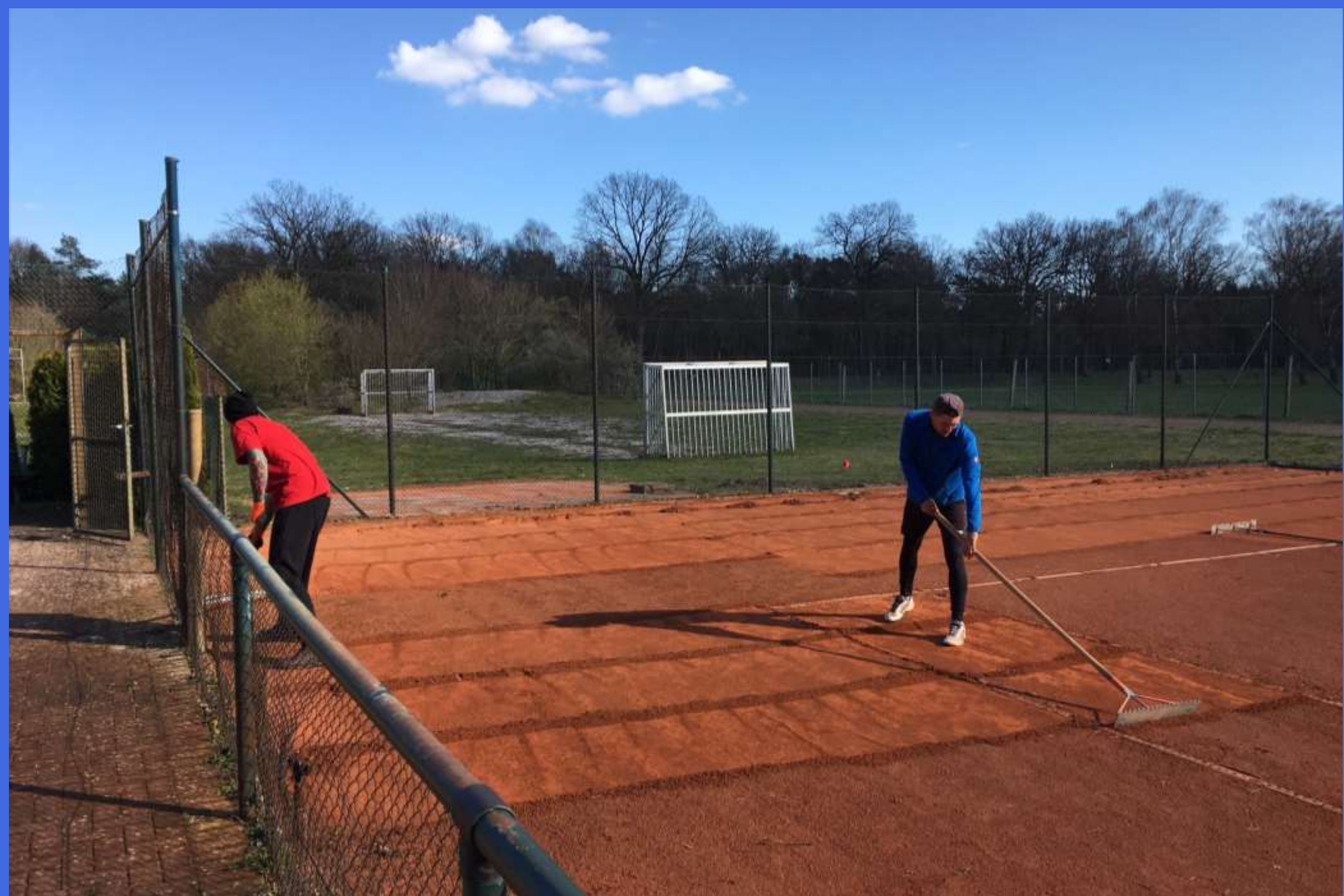
ASV Tennis – Platzinstandsetzung 2020 Die Mitarbeiter der Firma Meinecke tragen die alte Asche ab ...
