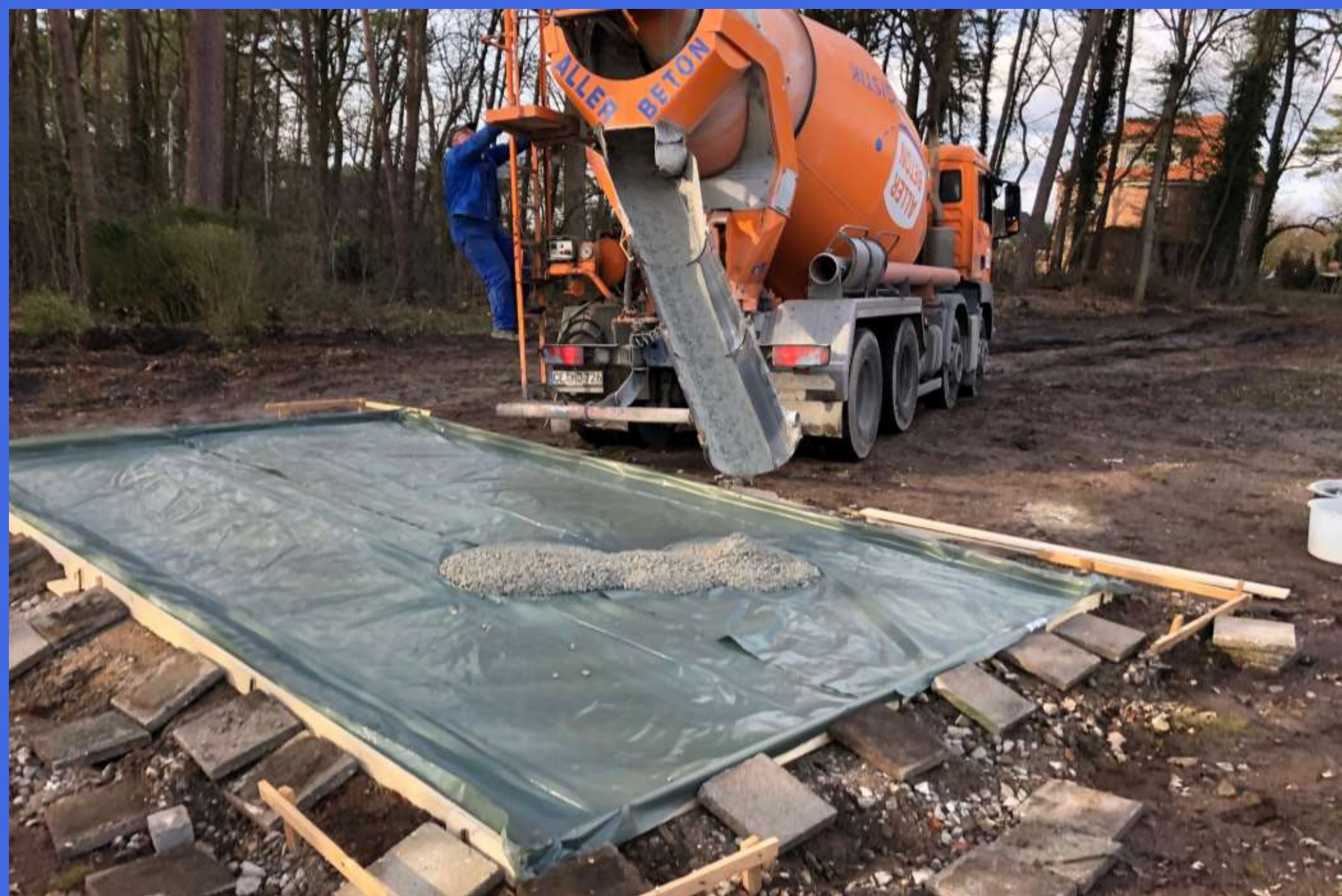
ASV Tennis – Umsetzung Garage & Carport 2020 Fundamentarbeiten für die neue Garage mit Hilfe von Aller-Beton
